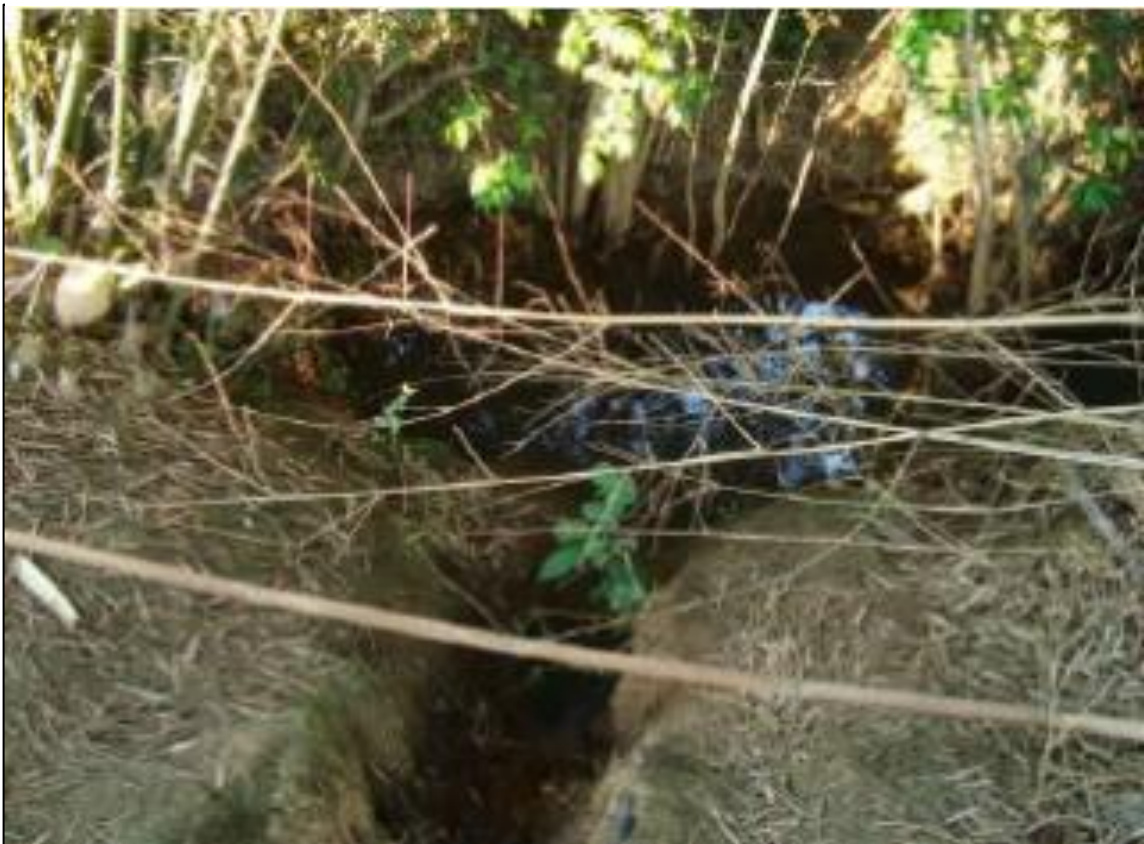
Figura 14: Ponto de lançamento de efluentes domésticos e industriais da sede municipal de Resende Costa
