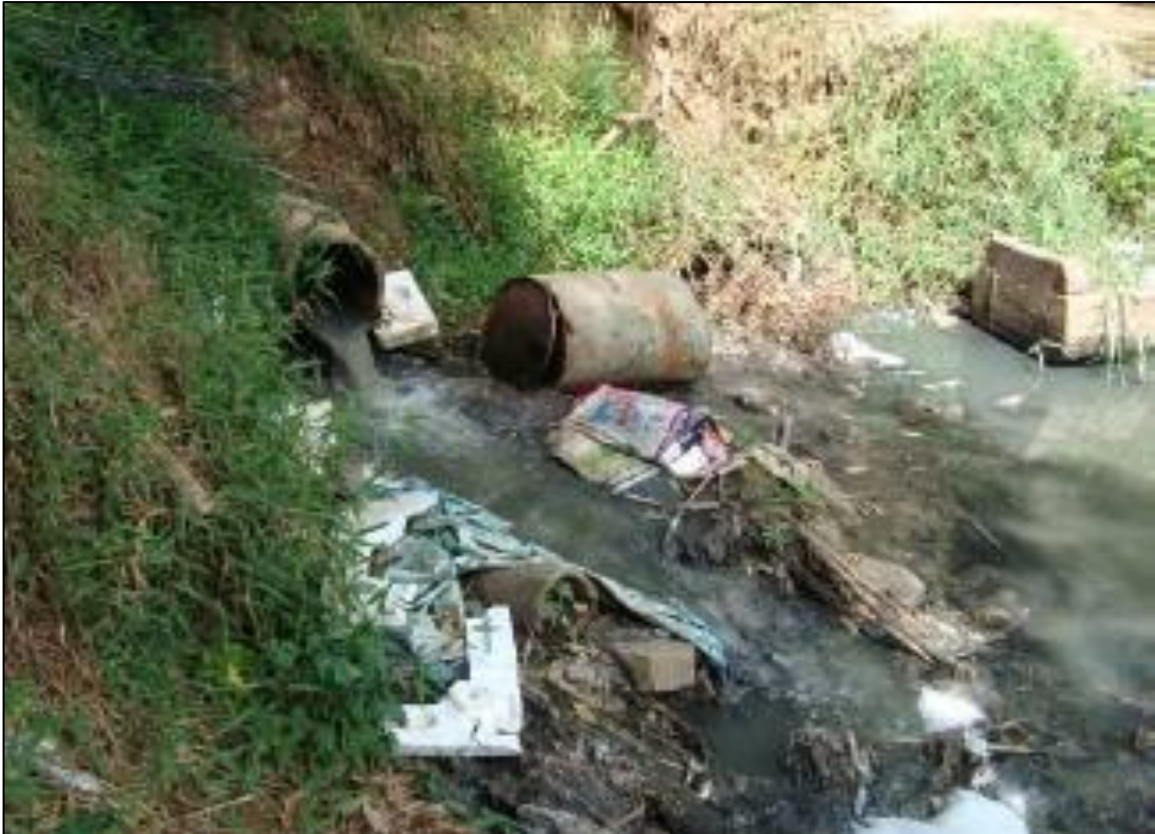
Figura 13: Ponto de lançamento de efluentes domésticos e industriais da sede municipal de Santa Cruz de Minas
